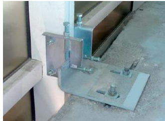
Typische Schrägzugbeanspruchung zum Rand
